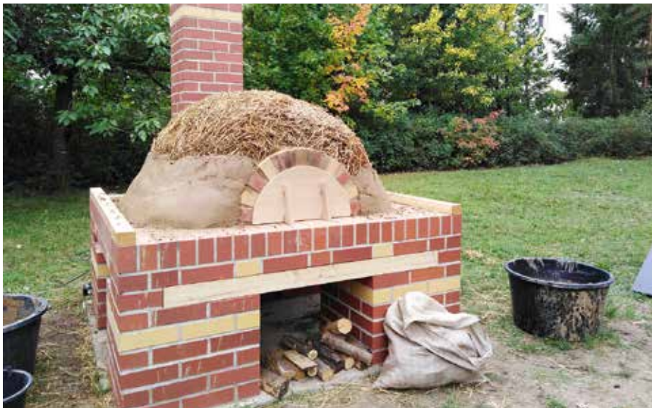
Der Lehmbackofen kurz vor der Fertigstellung
