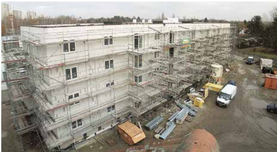
Webcam-Ansicht unserer Baustelle im Dezember
